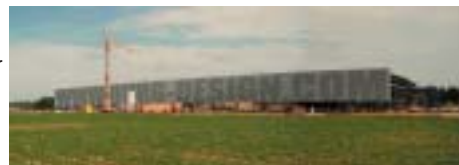
Burg Design – Errichtung des neuen Betriebsgebäudes
